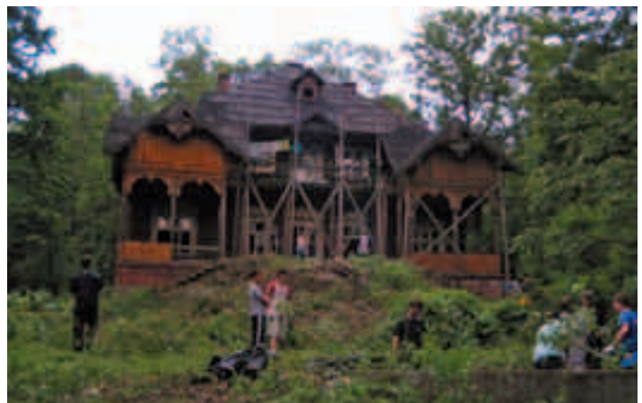
Czerwiec 2005 rok. Nadszedł czas odbudowy
