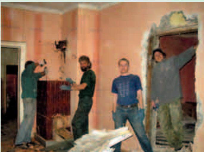
Budowa kominka w harcówce. Październik 2005 rok
