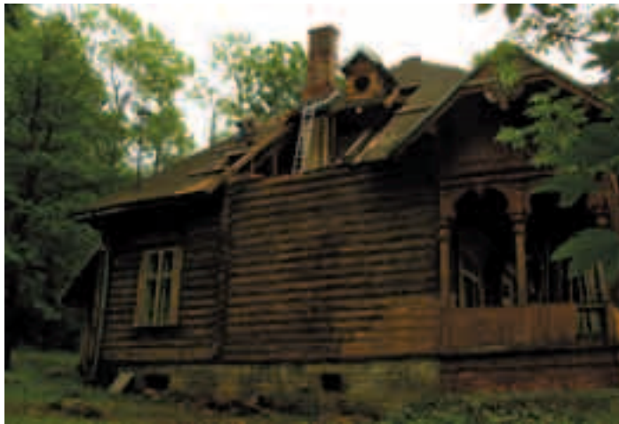
Czerwiec 2005 rok. Stowarzyszenie Lipnik naprawia dach
