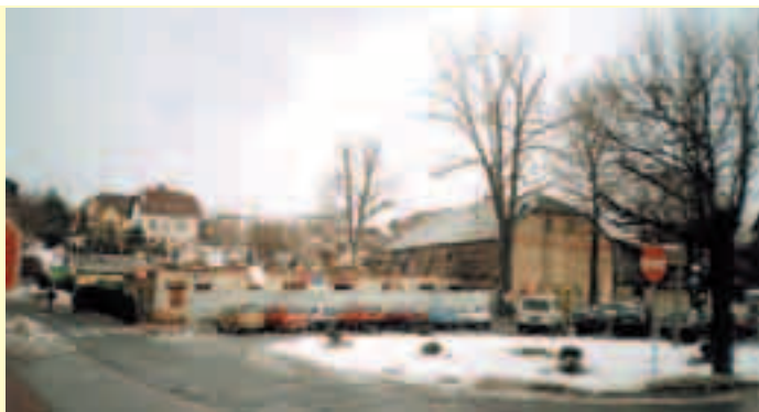
Dom Polski – w czasie remontu, styczeń 2005 rok
