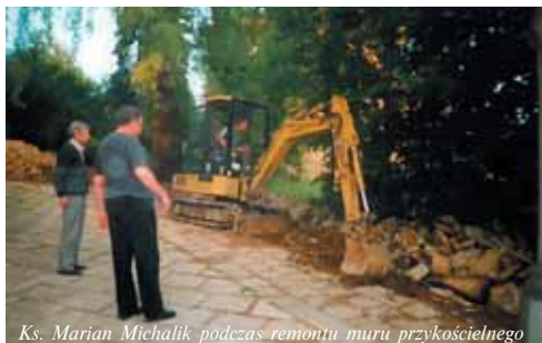
Ks. Marian Michalik podczas remontu muru przykościelnego
