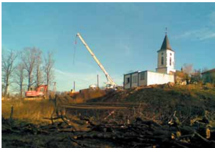
Pierwsze prace budowlane w Lipniku
